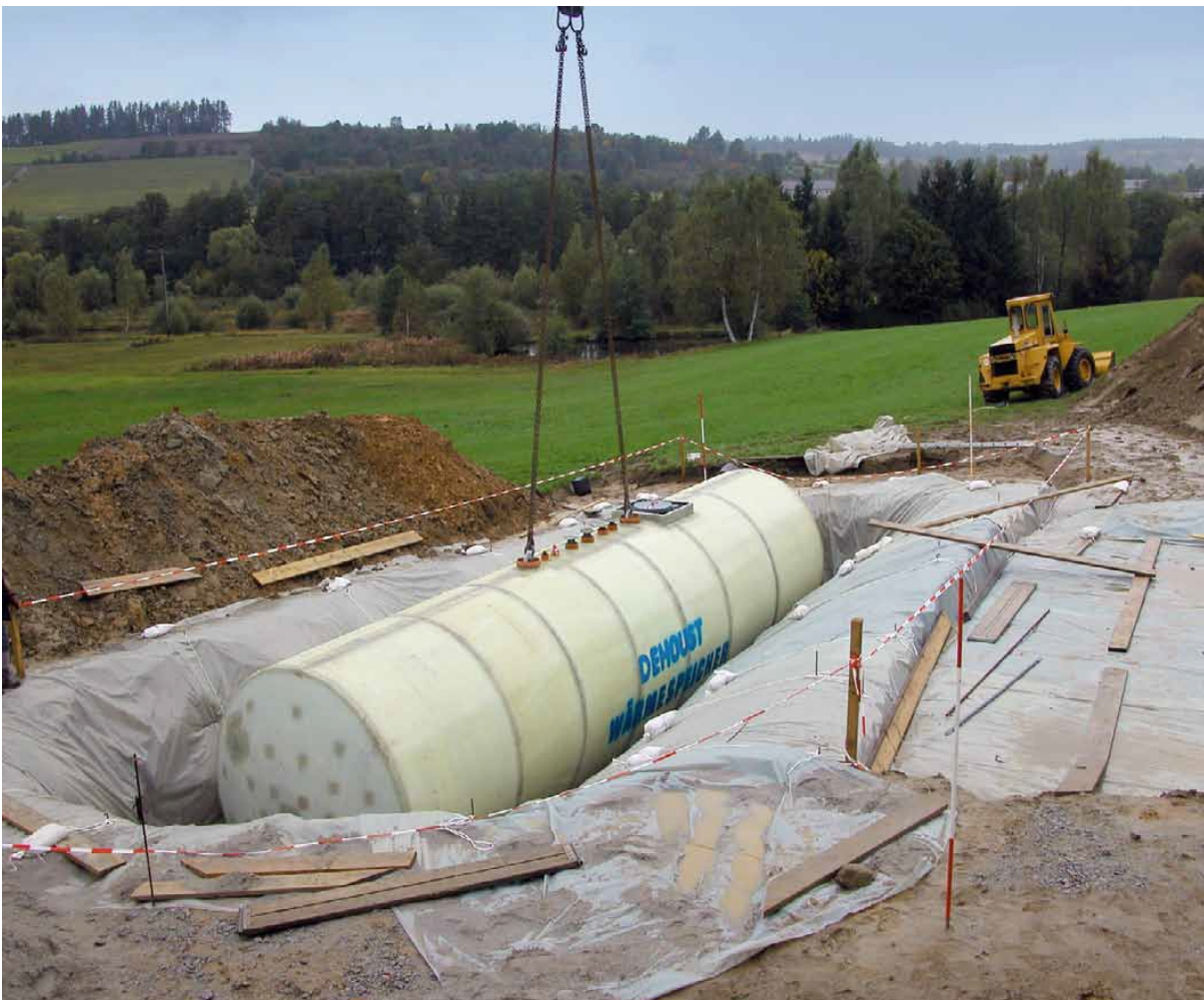
Fig. 90 Wateropslagtank Ondergronds Liggend 10.000 tot 100.000 Liter
